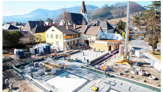
Der Kindergartenbau ist eine gelungene Chronik über Mut, Gemeinschaft und viele helfende Hände, geschaffen von regionalen Firmen – vom Baumeister bis zum Zimmerer, von der Haustechnik bis zur Elektrik.
