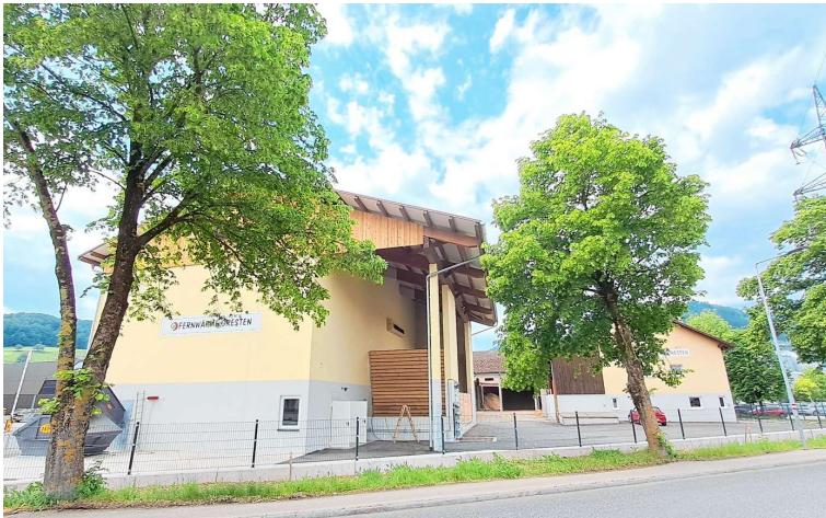
Ein Zubau beherbergt den neuen 4.000-KW-Heizkessel der FWG Gresten.
